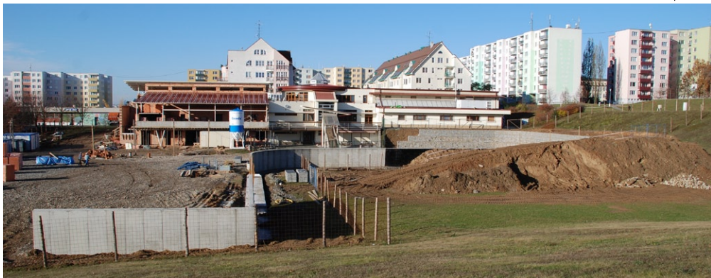
Listopad 2009 – stavba budovy střediska a terénní úpravy pro budoucí hřiště.
