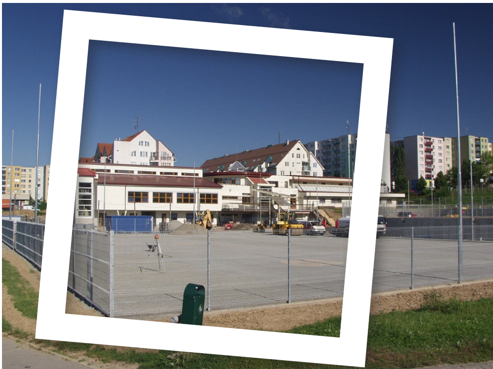
Červen 2010 – budova střediska je téměř hotová, hřiště čekají na konečnou úpravu.
